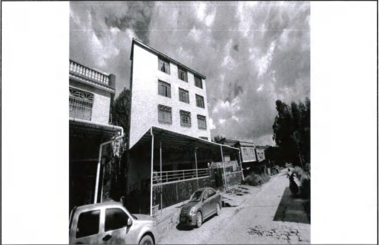
图 1 建筑外观现状
