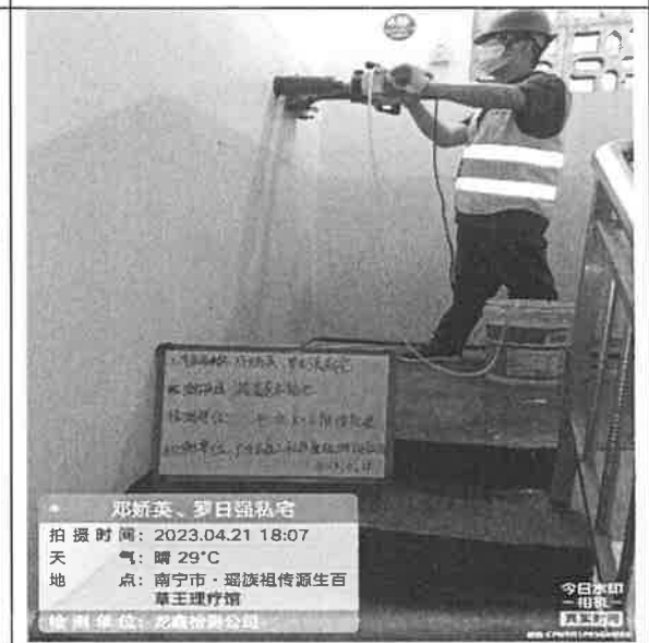
钻芯法检测梁混凝土强度
