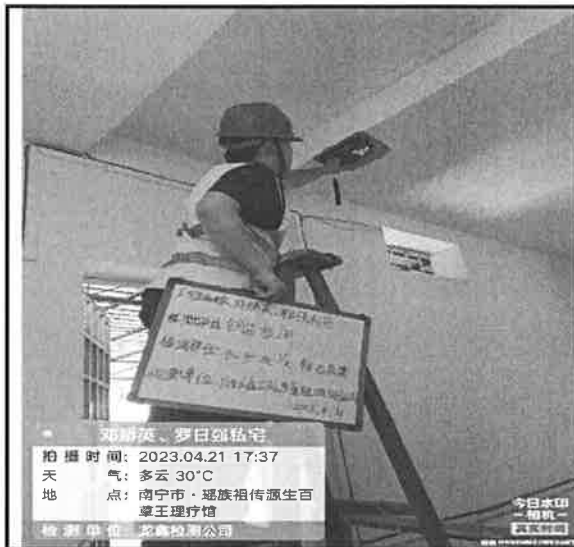
梁钢筋配置检测
